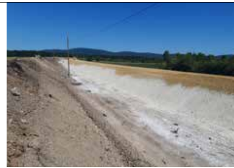
A földmű zárórétégre beépített SZK1 jelű kiegészítő réteg
