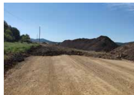
Kitermelt töltéstalajok visszaépítése a második 50 cm-es réteg stabilizálásához
