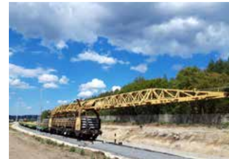
Vágánymezők fektetése Platov daruval
