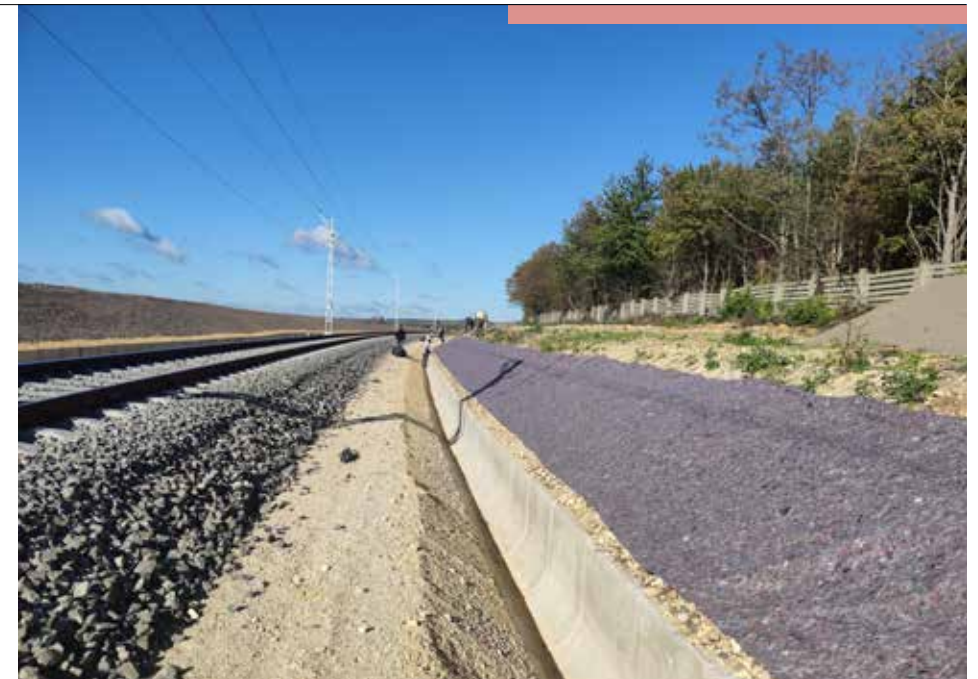
Rézsúvvédelem fűmagos geotextília beépítésével
